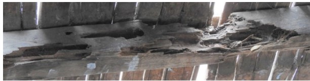
Bild: Beinahe durchfaulte Holzkonstruktion
