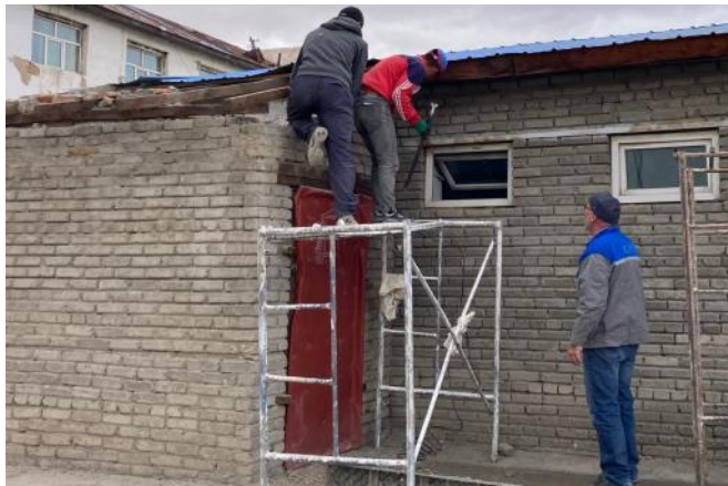
Bau eines Vorrums zur Dusche der Schule
